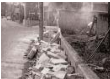
昭和53年6月、宮城県沖地震発生
