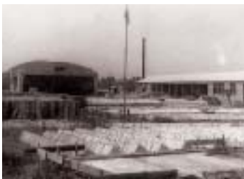
昭和36年6月、工場誘致第1号、株式会社特殊コンクリート工法の進出決定
