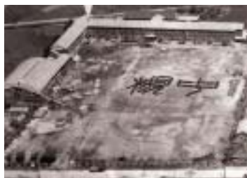
昭和31年、建設中の槻木中学校体育館
