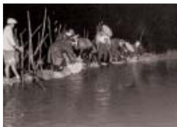
昭和32年7月、豪雨のため五間堀堰堤が決壊
