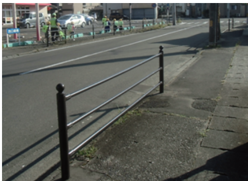
歩行者の安全確保のための交通防護柵の整備
