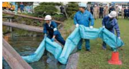
▲流出油の拡散を防止するオイルフェンスを設置
