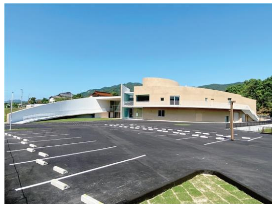
熊野東防災交流センター
