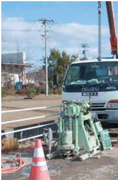
下水道工事現場
