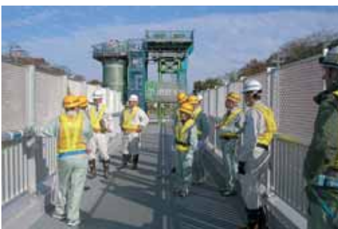
(仮称) さくら連絡橋建設工事現場
