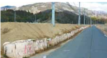
工事が進む町道富沢16号線
