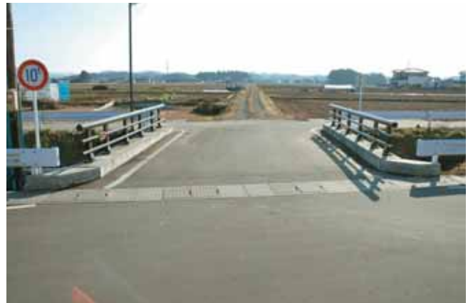
拡幅された剣崎1号橋
