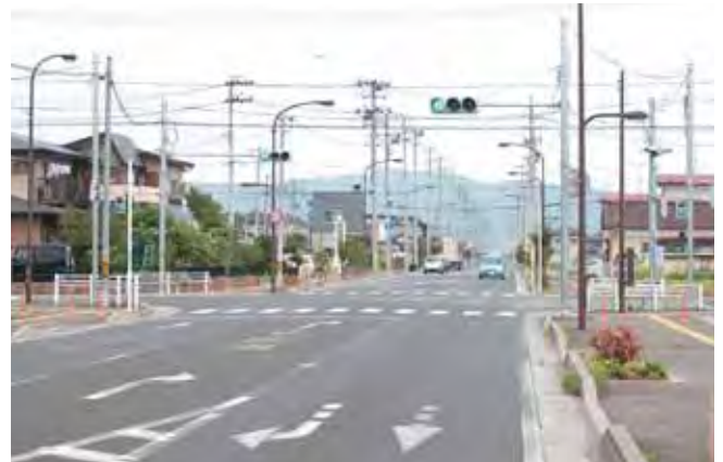
新栄通線に設置された信号機
