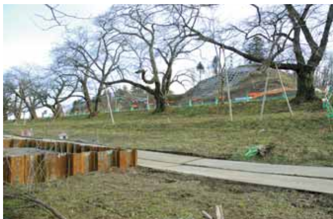
白石川から見た工事現場
