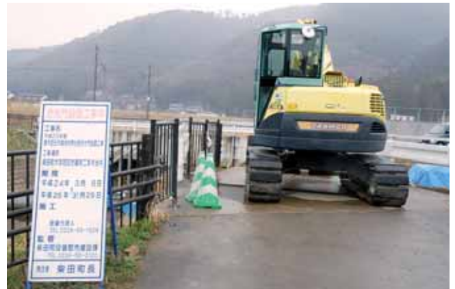
進む稲荷山用水路分水門工事
