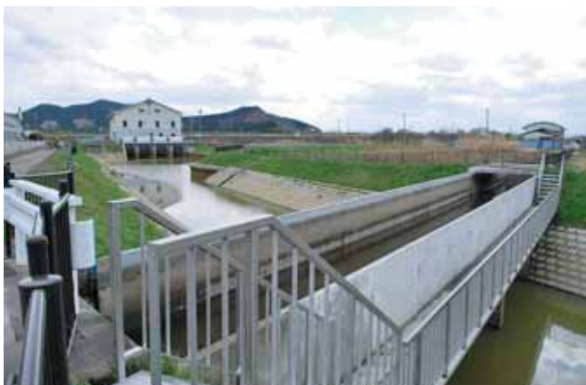
分水門が設置される名取用水(稲荷山用水)
