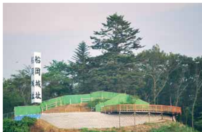
補強工事をして9月完成を目指す展望デッキ
