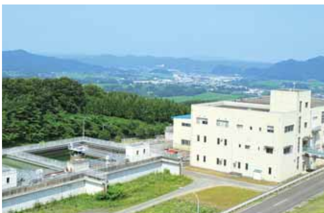
柴田町に送水している南部山浄水場(白石市)
