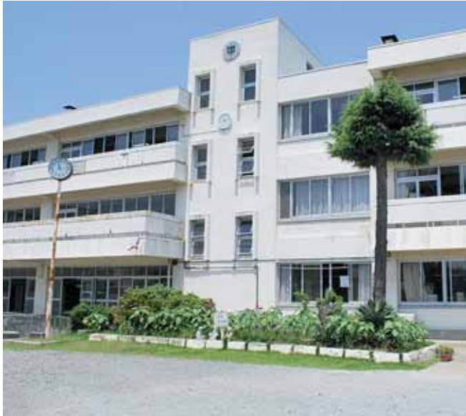
12月から解体が始まる槻木中学校
