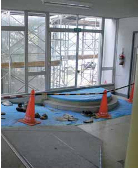
順調に進む大規模改造(槻木小学校)
