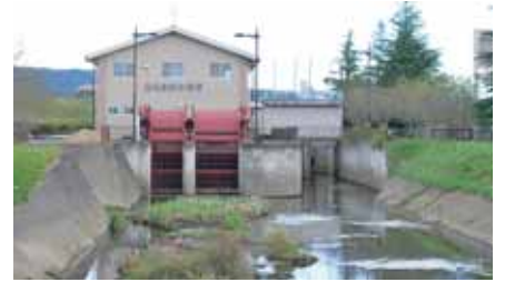
住宅冠水防止も兼ねる排水機場
