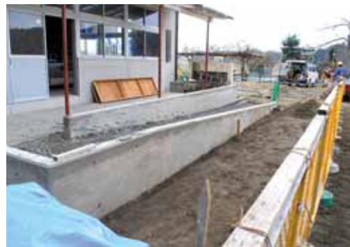
バリアフリー化など着々と進む改修工事
