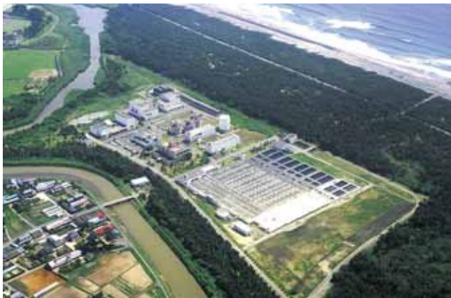
下水を処理する県南浄化センター(岩沼市)
