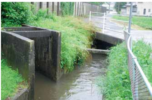
大原町と連携して進められる鷺沼排水路の改修
