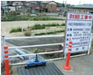
工事が始まった船岡西2丁目
