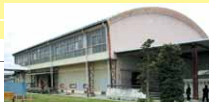
建て替えに着手する船岡中学校体育館
