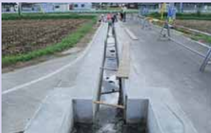
下水道の工事
