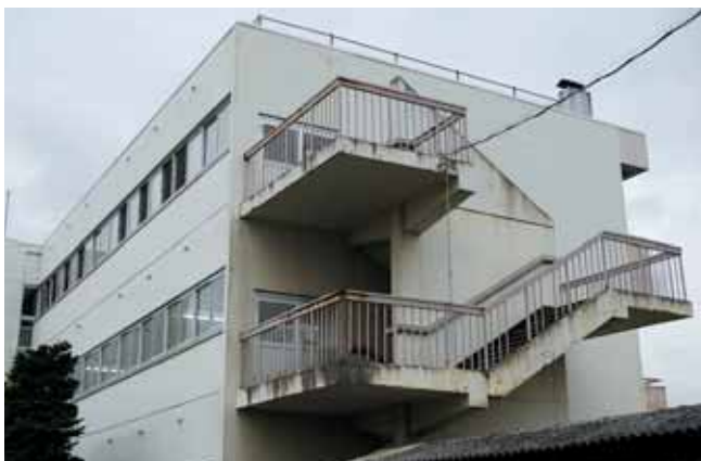
22年度に改修予定の船岡中学校の校舎
