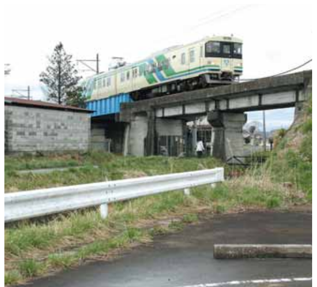
阿武隈急行高架橋の交差部分
