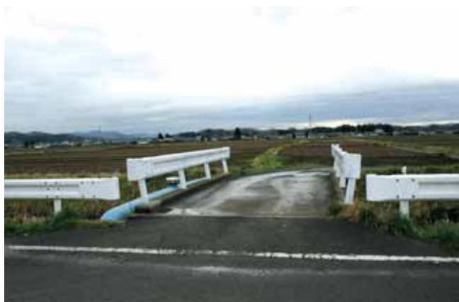
剣崎地区の橋りょう
