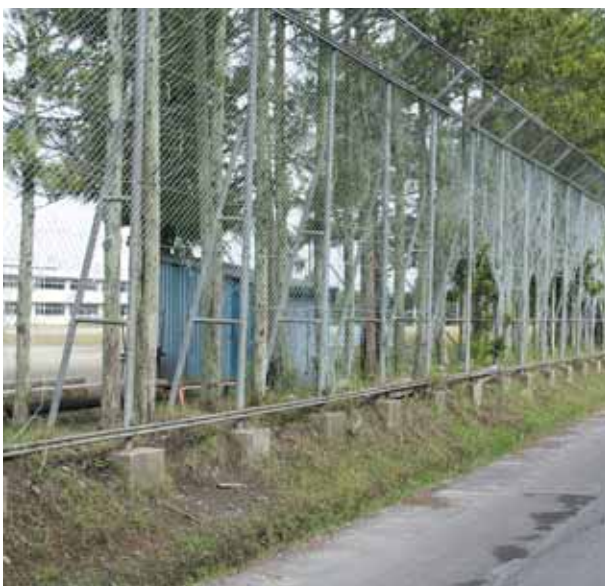
まもなく改修される船岡中学校ネットフェンス
