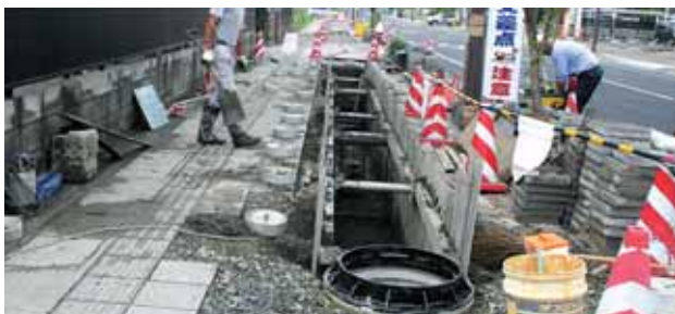
新栄地区の下水道工事
