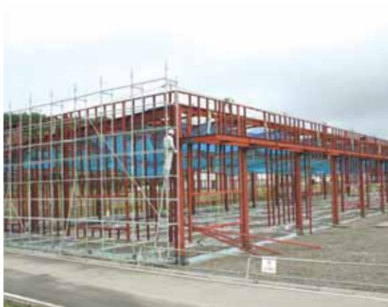
船岡工場団地内に新築中の工場
