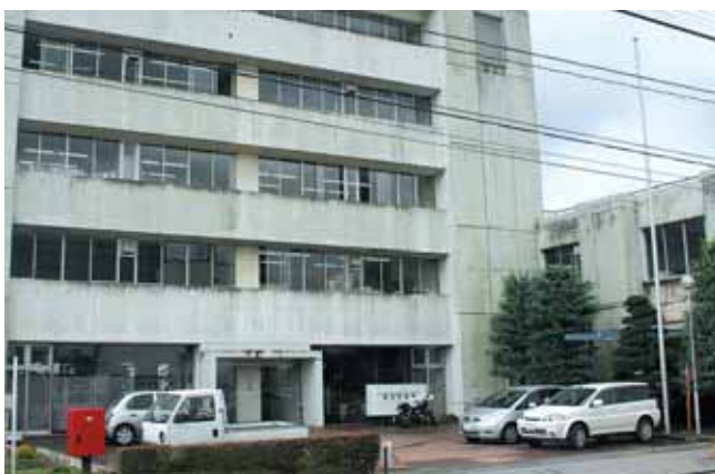
耐震診断が待たれる柴田町役場庁舎
