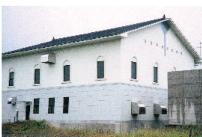
四日市場の新排水機場
