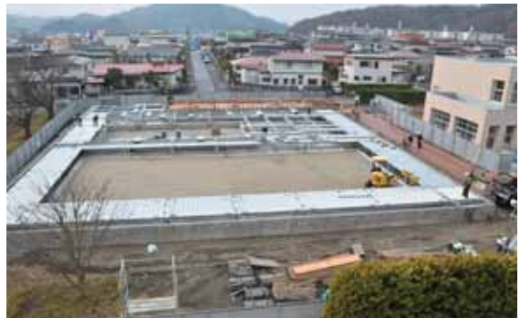
工事が進む船迫小学校プール
