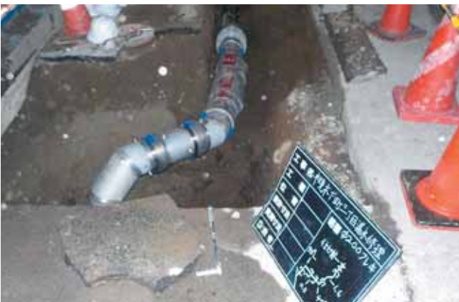
槻木下町の漏水修理
