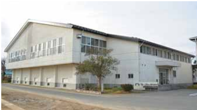
外壁の改修を行う槻木中学校体育館
