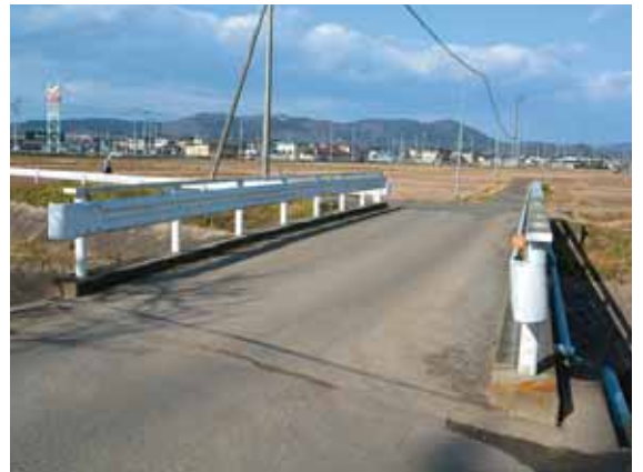
58年経過した船岡五間堀8号橋
