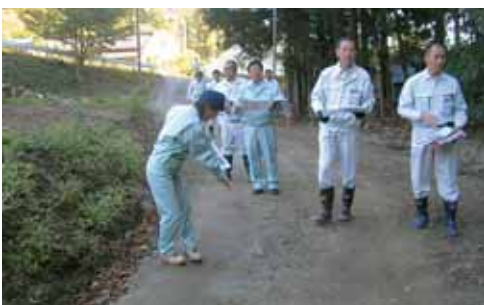
関東・東北豪雨の被害調査（葉坂地区）
