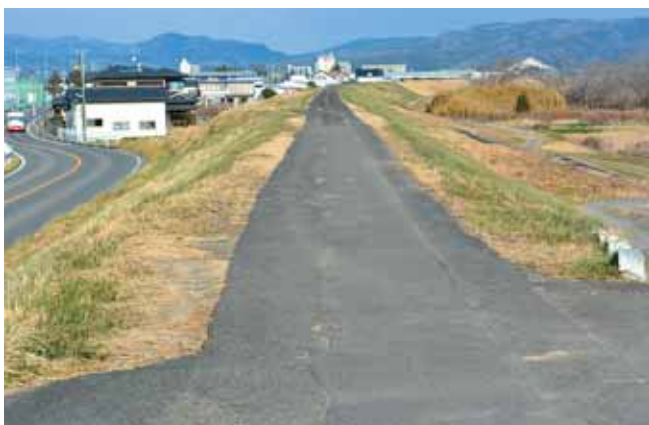
早朝の拡幅工事が望まれる阿武隈川の土手
