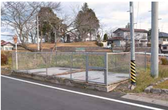
葛岡地区にある防火水槽
