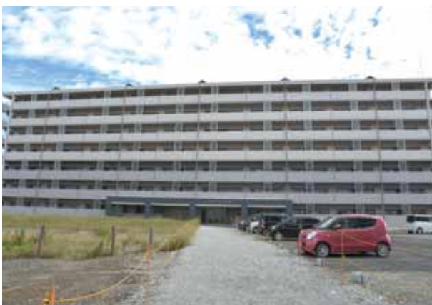
完成した北船岡町営住宅3号棟
