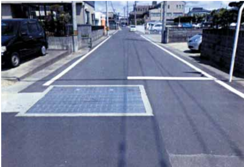
完成した排水路（槻木郵便局付近）
