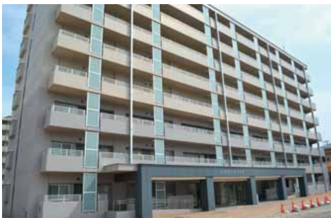
北船岡町営住宅
