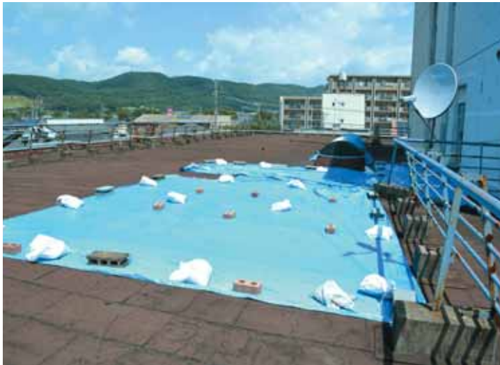
役場庁舎屋上
