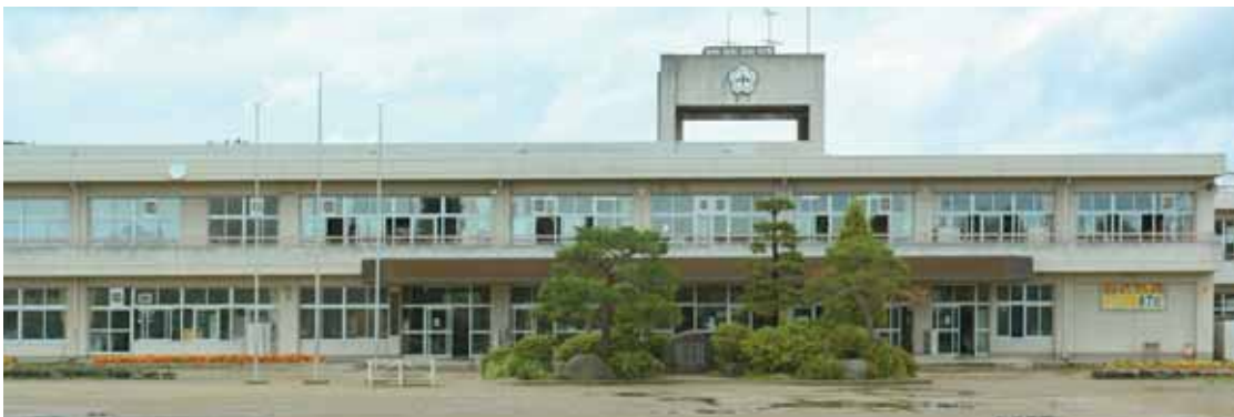
大規模改造が進む船岡小学校
