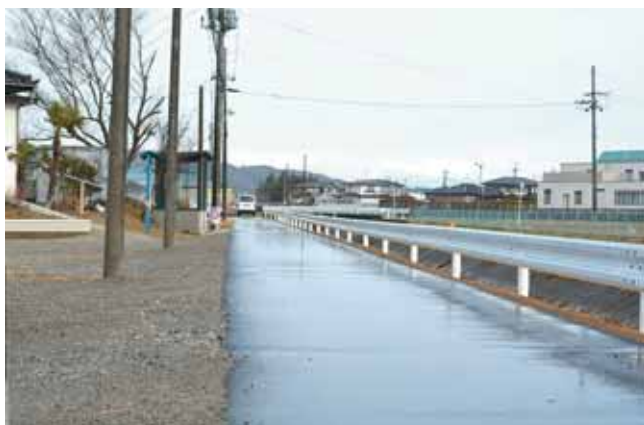
安全対策が望まれる剣水集会所前
