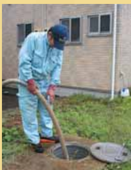
浄化槽の汚泥の引抜き作業を行う渡辺さん。
