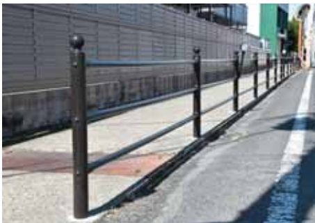
歩行者の安全確保のための 交通防護柵の整備
