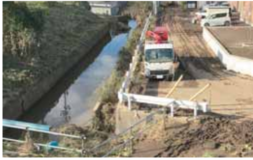
台風通過後の古河水門へつながる排水路
