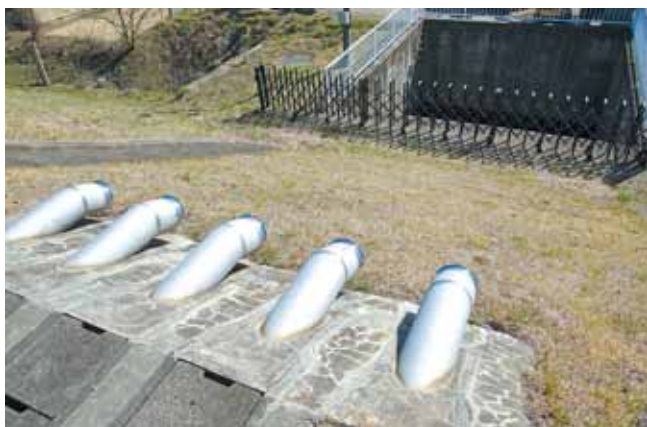
須川前樋管と排水ピット
