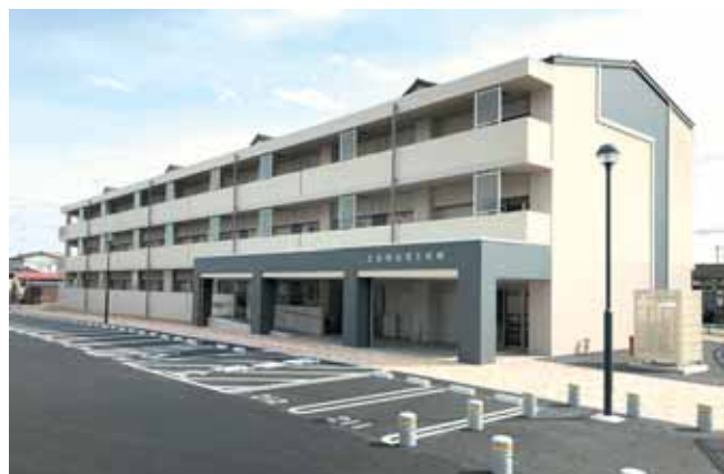
完成した北船岡町営住宅5号棟
