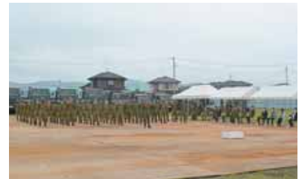
造成工事が始まった (仮)総合体育館建設予定地
