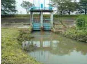
開閉装置の改修が決まった古河水門
