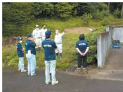
令和元年台風19号災害復旧状況確認
