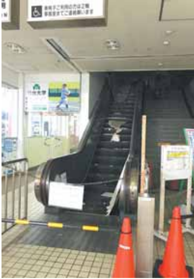
地震により天井板が落下した JR 船岡駅 (2月18日撮影)
