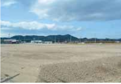
避難所にもなる新体育館建設予定地
