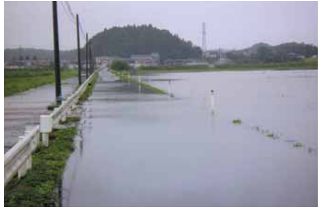
繰り返す道路冠水(槻木地区)
