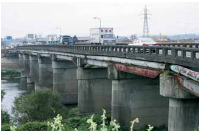
白幡橋の現況
