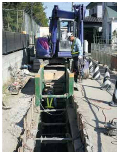
下水道工事(船岡七作地区)
