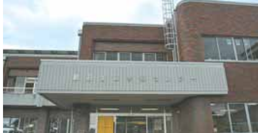
ホールの床が修繕されました
